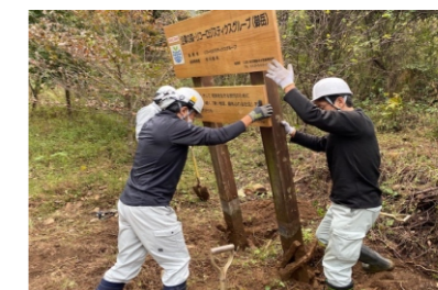
ご注文製品の組み立て、設置工事
